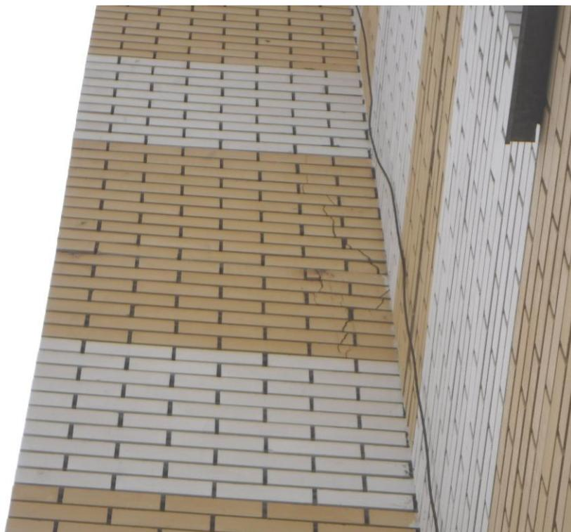
Отрыв кладки по стене в осях «б/Г-Д»
