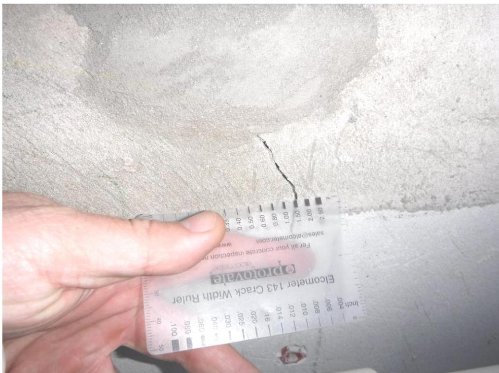
Измерение ширины раскрытия трещины линейкой для расчета ширины трещин
