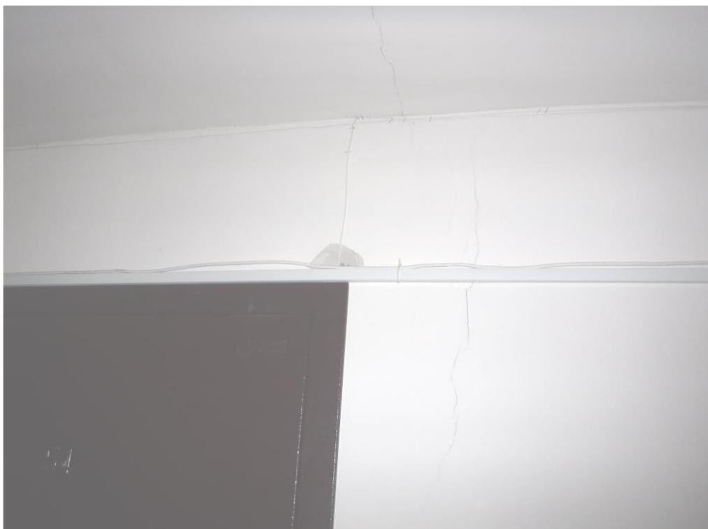
Трещины по стене и русту на лестничной клетке 4-го этажа в осях «7/В-Г»
