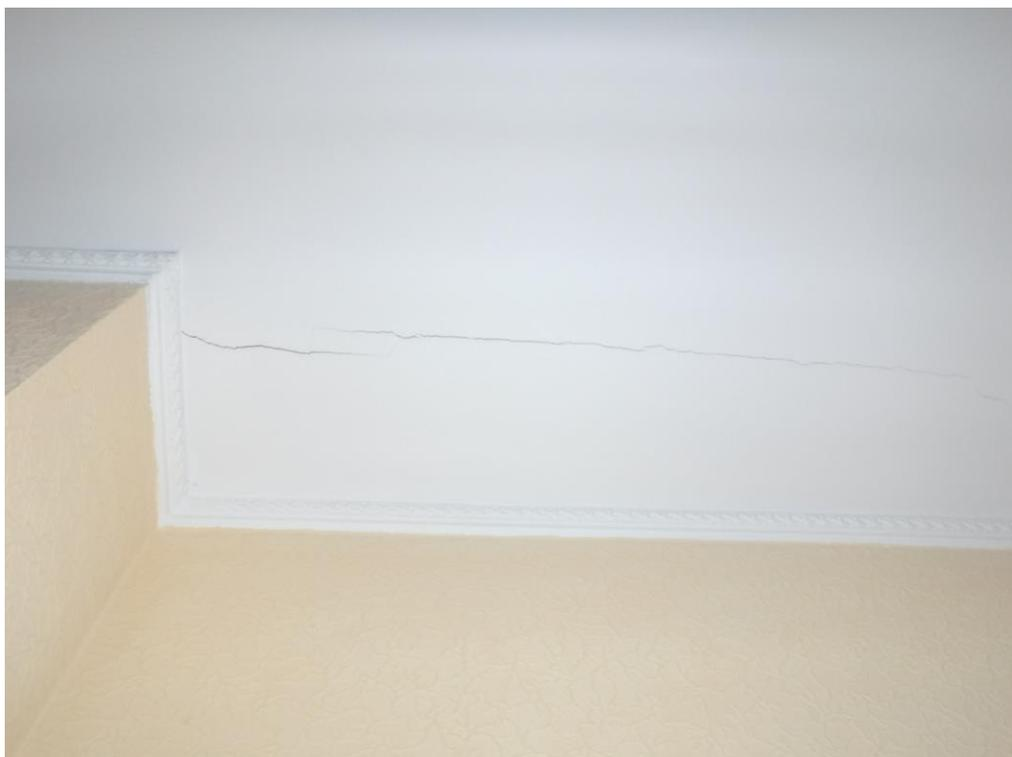
Трещина по русту плит перекрытия на 7-ом этаже в осях «6-7/Б-Г»
