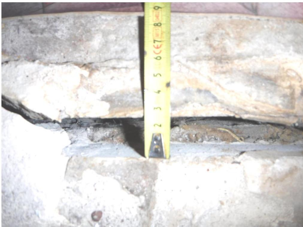
Измерение расхождения конструкций при помощи рулетки FISCO UM5M
