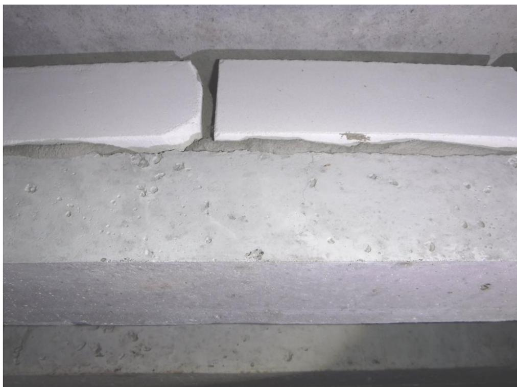
Поперечная трещина в перемычке дверного проема технического этажа
