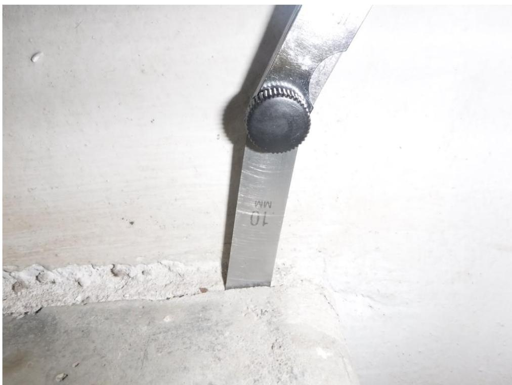
Определение ширины раскрытия трещин между стенами и лестничным маршем с помощью наборов шупов
