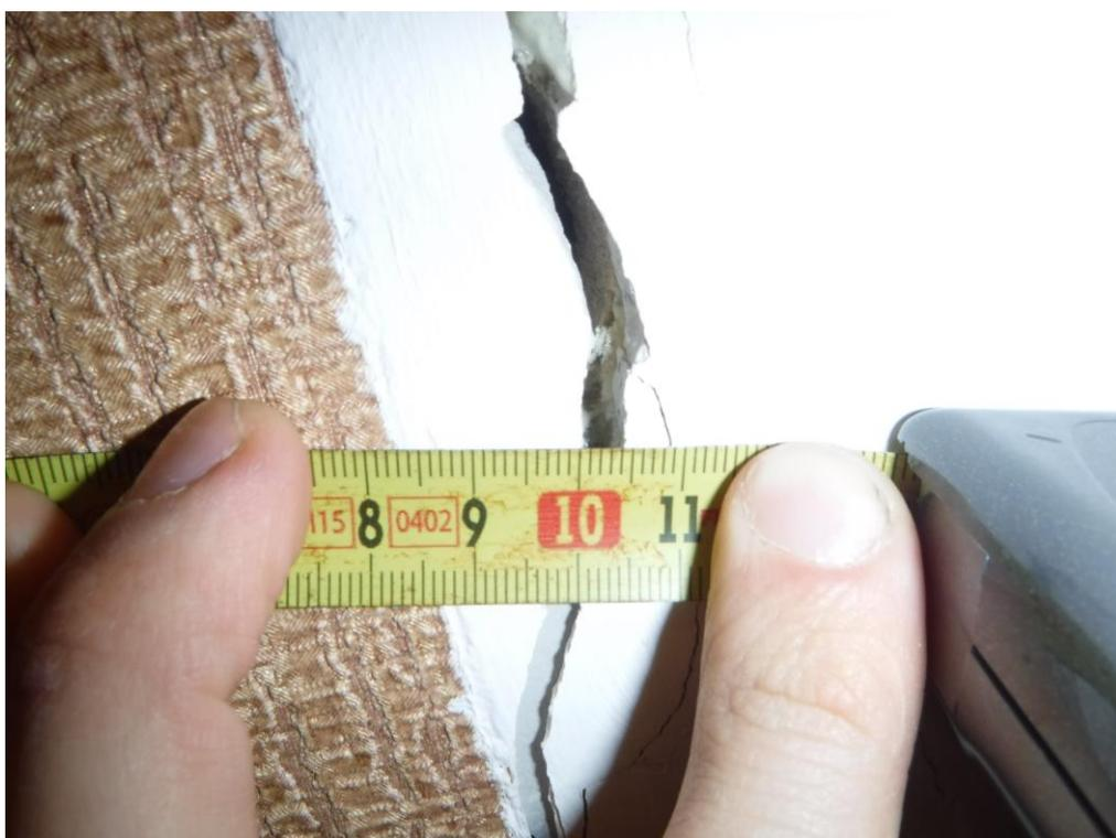
Измерение ширины раскрытия трещины на 9-ом этаже в осях «8-9/В-Г»
