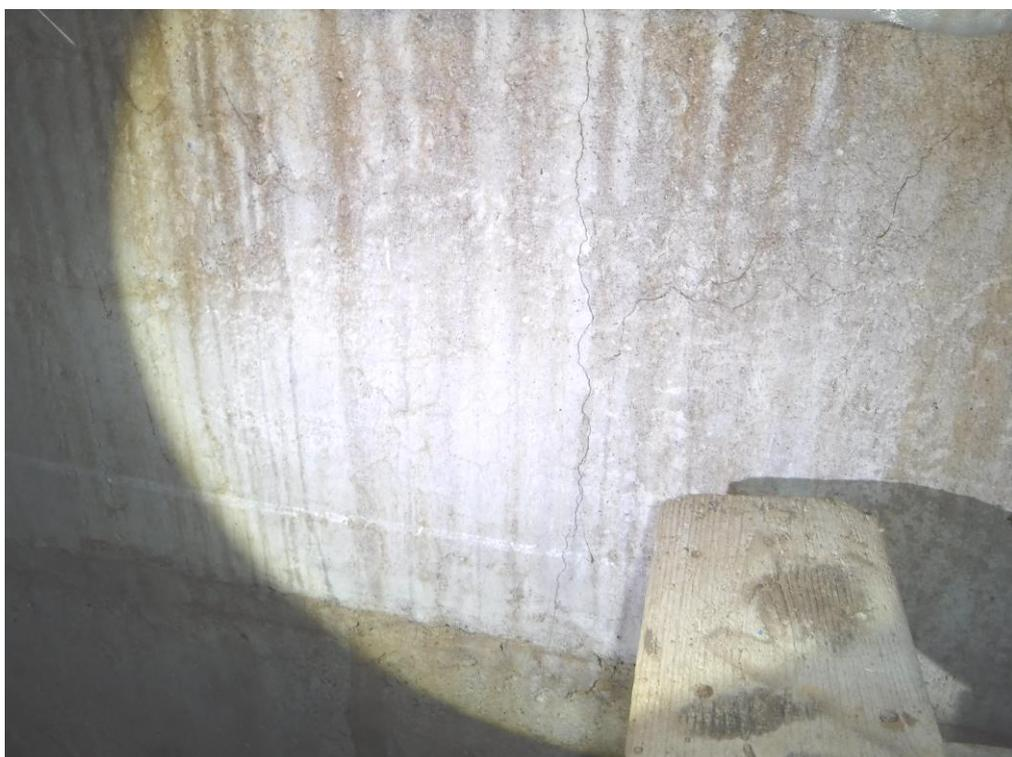
Вертикальная трещина по фундаментным блокам в осях «2-3/Д»
