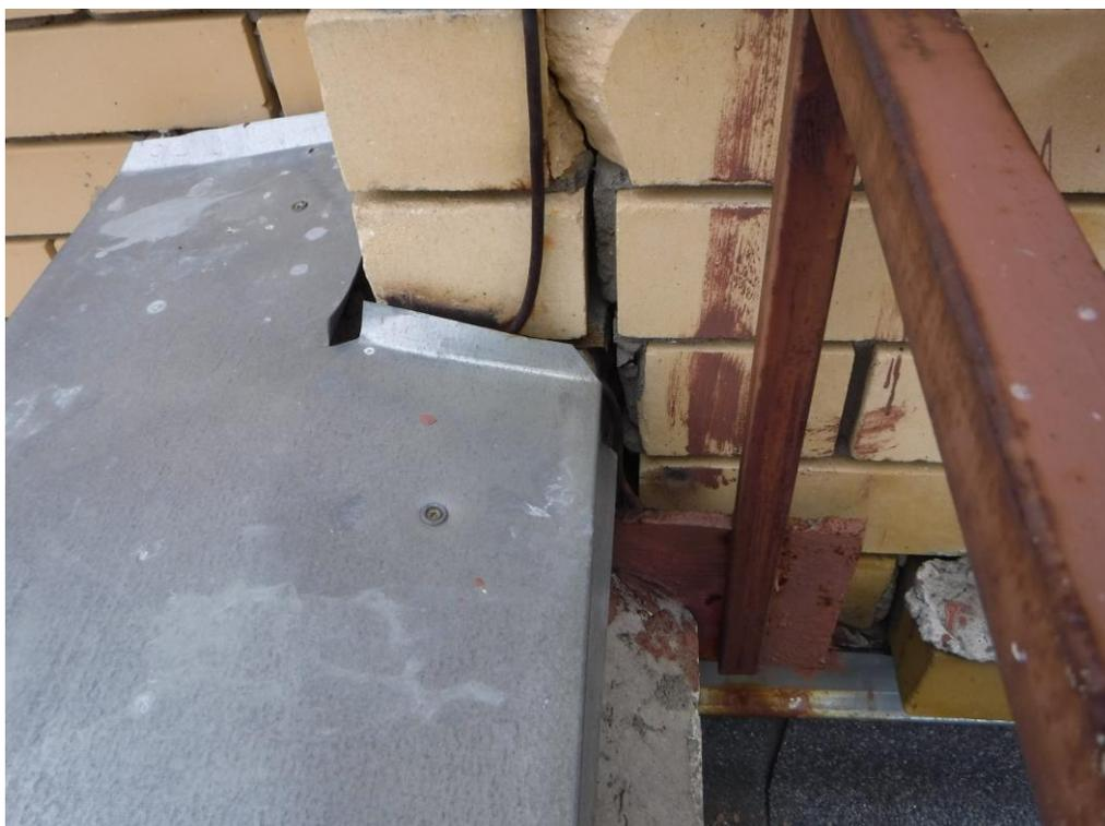
Отрыв кладки на кровле в осях «9/Г»
