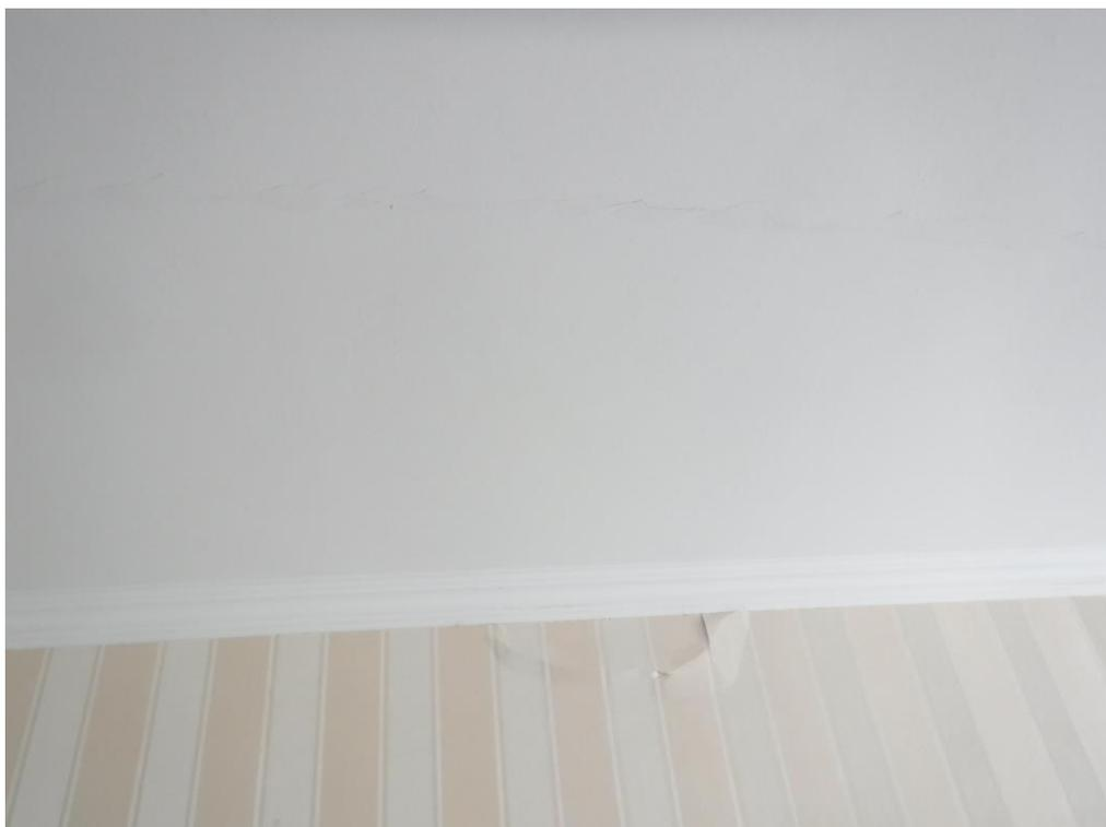
Отслоение штукатурного слоя и обоев на 7-ом этаже в осях «7-8/Б-В»
