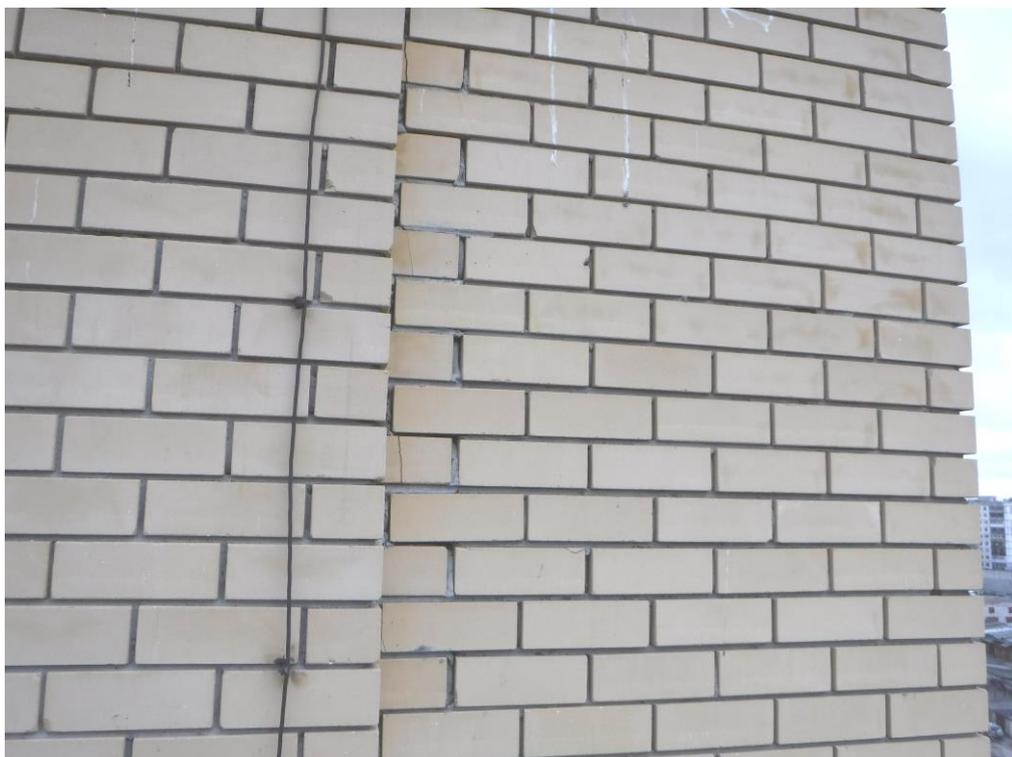
Вертикальная трещина по кладке в осях «7/Д»
