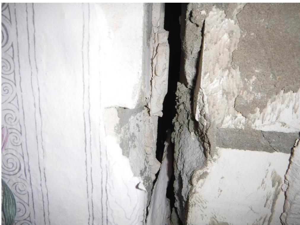
Трещина в месте примыкания перегородки на 10-ом этаже в осях «8-9/В-Г»
