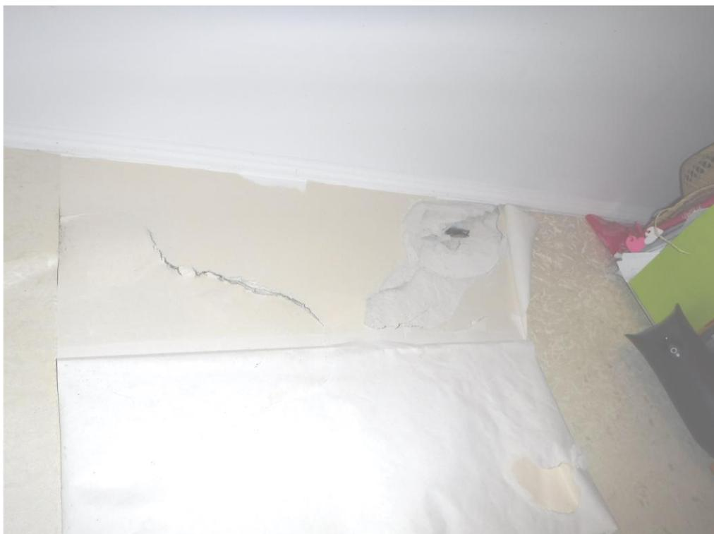
Отслоение штукатурного слоя и обоев на 5-ом этаже в осях «8-9/В-Г»
