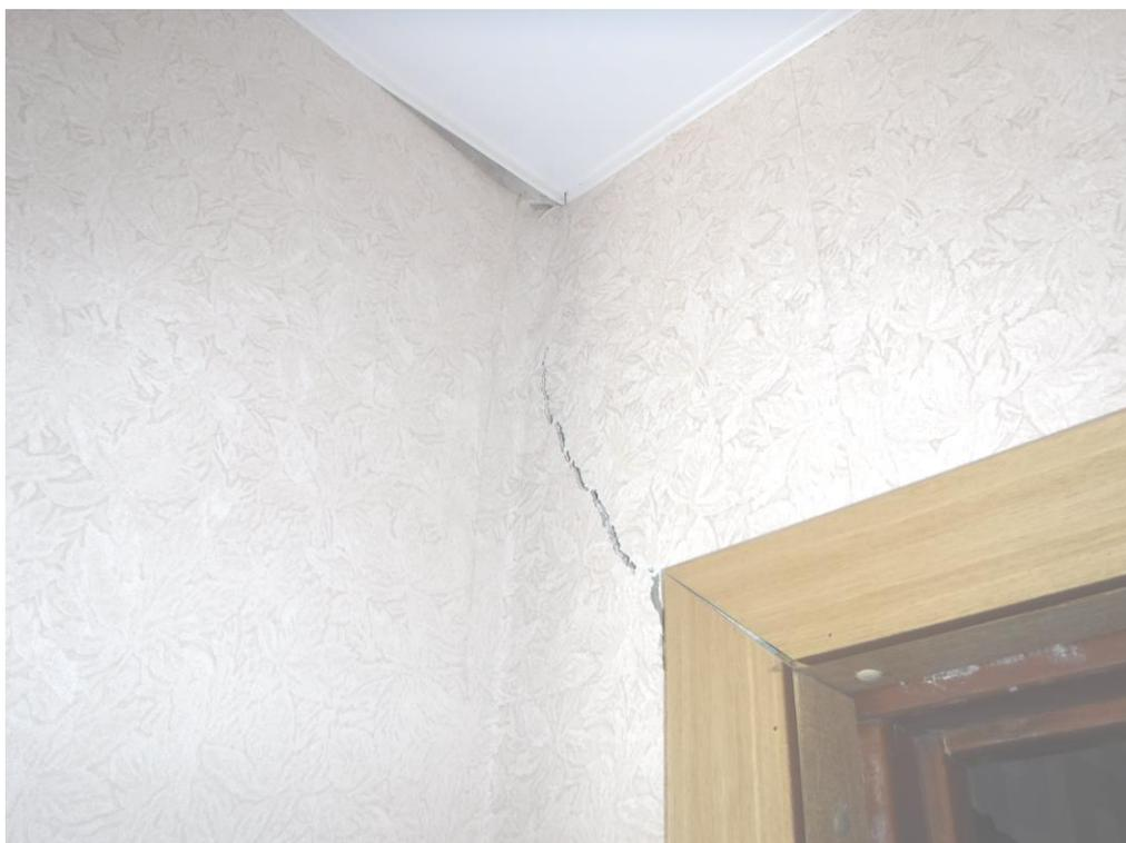
Трещина на 7-ом этаже в осях «8-9/В-Г»
