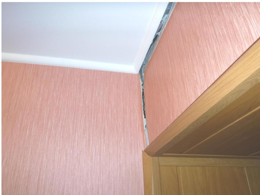
Отрыв стены на 8-ом этаже в осях «9/В-Г»
