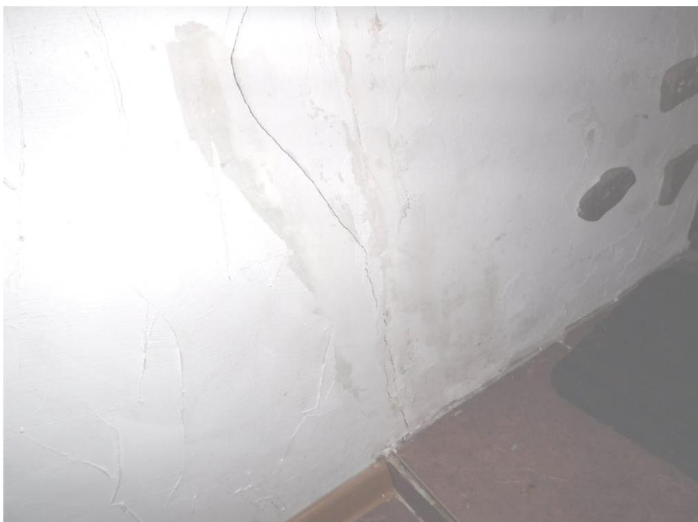
Вертикальная трещина на 5-ом этаже в осях «8-9/В-Г»
