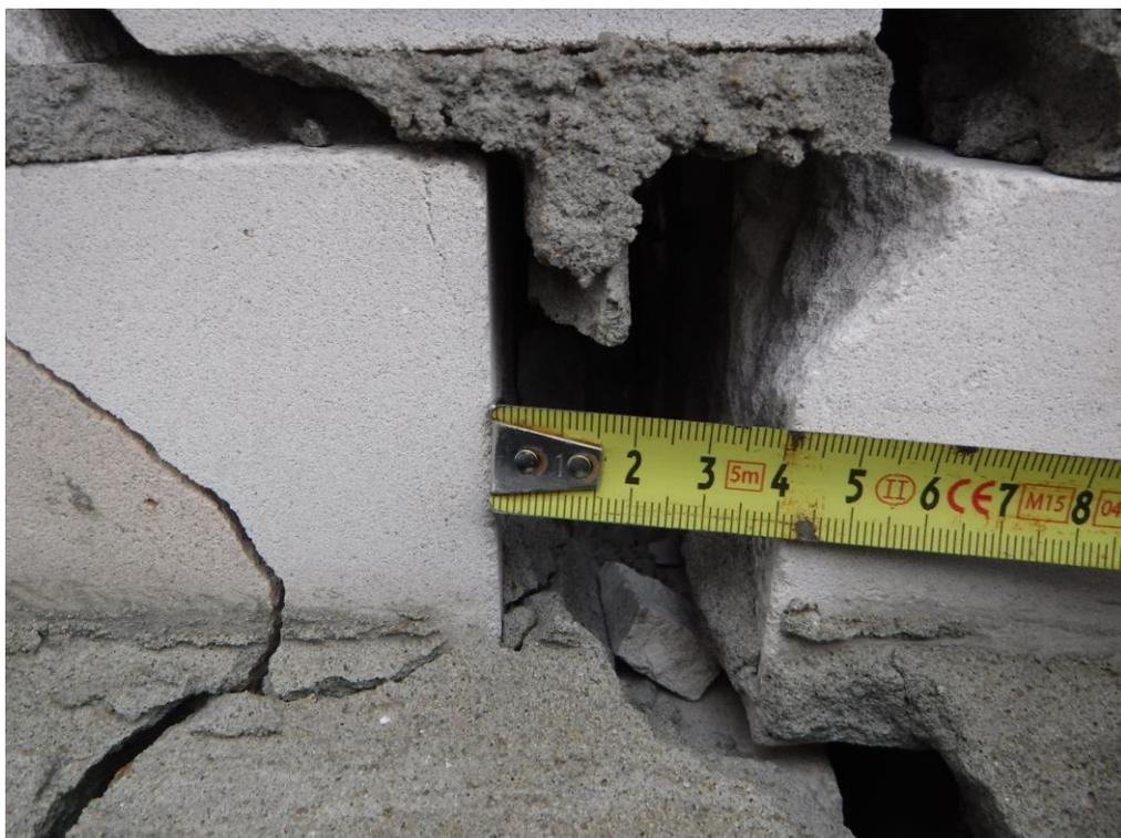
Трещина по кладке кровли в осях «6/А»
