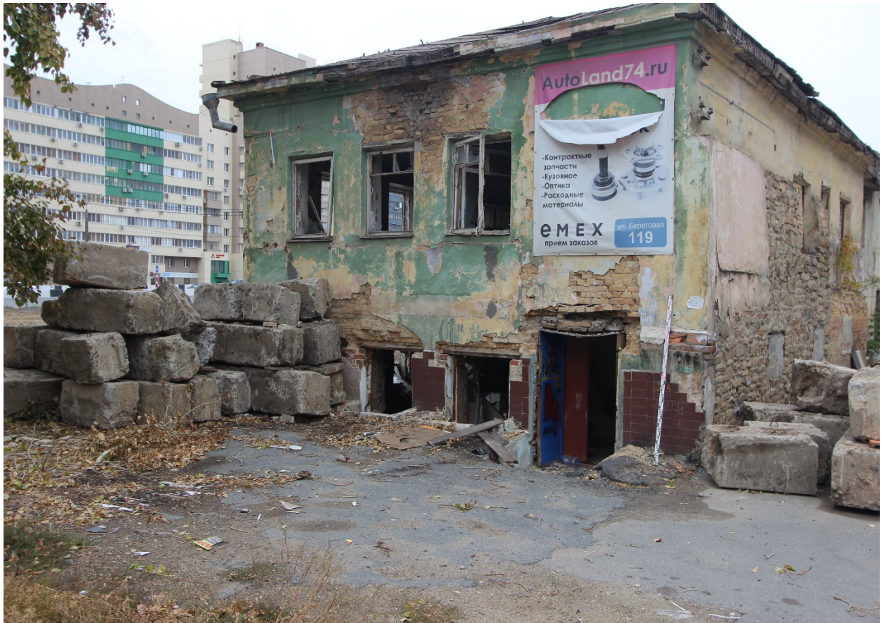
Рис. 24. Территория земельного участка с кадастровым номером 74:36:0614007:13, ул. Береговая, 119. Точка фотофиксации №3. Вид с юго-запада.
