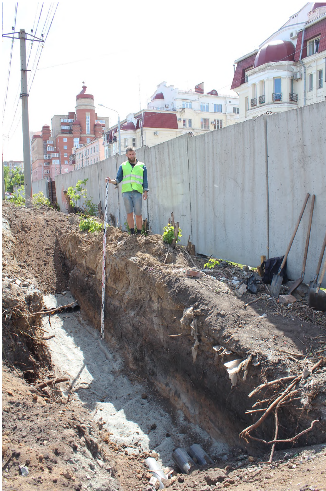
Рис. 66. Траншея на Пушкина, 15. Западный борт.
