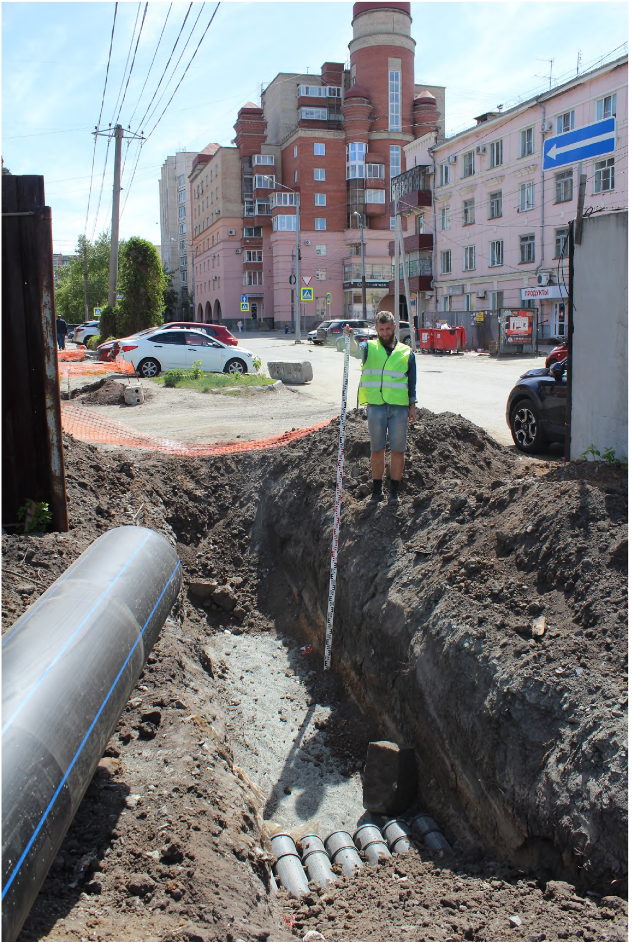
Рис. 68. Траншея на Пушкина, 15. Западный борт.
