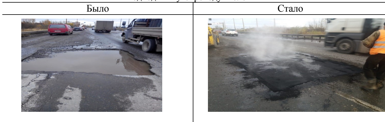
Подходы к путепроводу Молот
