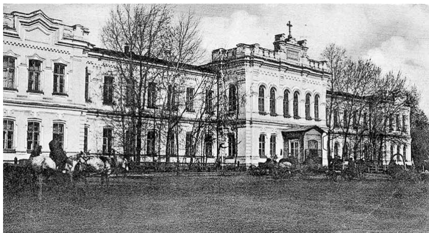
Здание женской гимназии, построенное в 1882 году (ныне торгово-офисное здание, ул. Ленина, 10)
