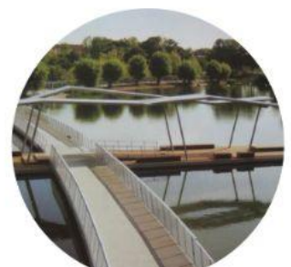
Понтонный мост с навесом
